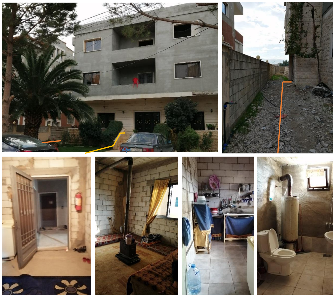
Figure 2. Exemple d'un bâtiment de cinq appartements dont plusieurs ont été réhabilités grâce au programme
